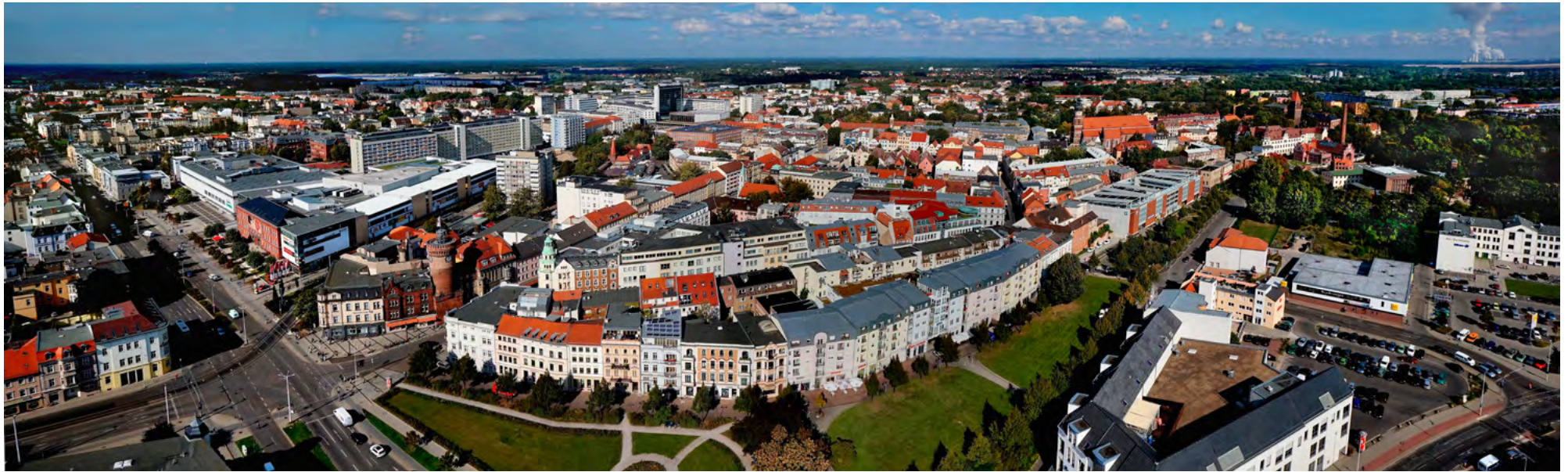
Das Fernwärmenetz der Stadtwerke Cottbus erreicht in der Innenstadt immer mehr Privat- und Gewerbekunden und versorgt sie zuverlässig mit nachhaltig erzeugter Wärme aus Kraft-Wärme-Kopplung (KWK).
