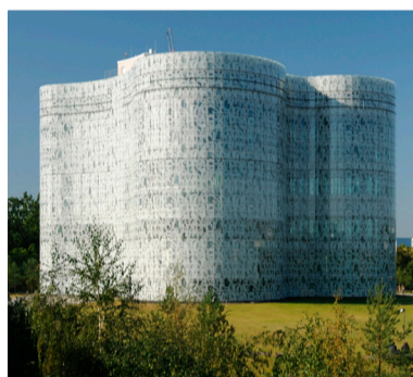
Die Uni-Bibliothek löste alte Erdgas-Technik durch einen Fernwärmeanschluss ab und spart dadurch in erheblichem Maße Kosten ein.
